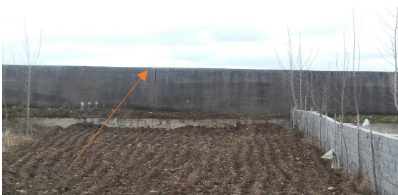
سیل‌بند تاریخی روستای فرح‌آباد هرازپی. (۱۳۹۶/۱۲/۴-ش). این دیوار از جنس سیمان و فلز بوده و قدمت آن به عصر پهلوی دوم می‌رسد.
