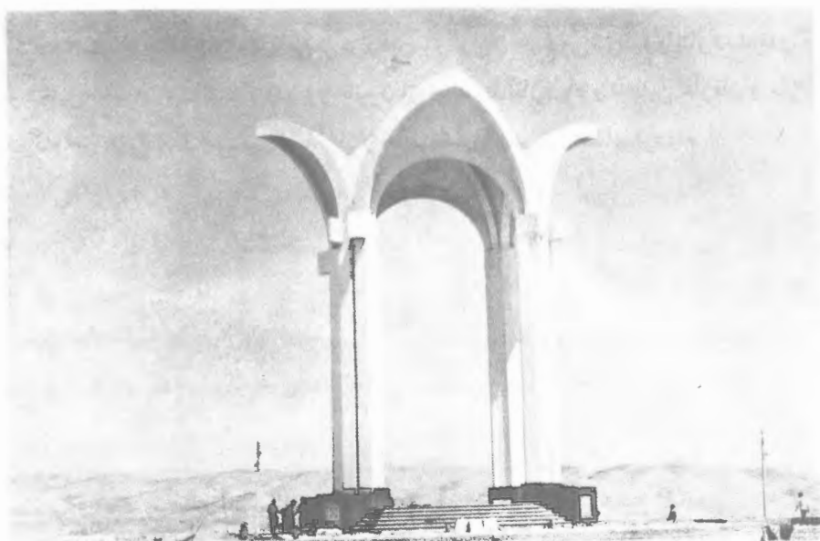
آرامگاه جدید و در دست احداث مخدومقلی فراغی - سال ۱۳۷۹
