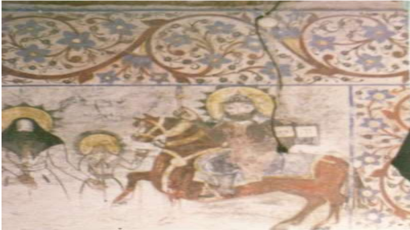
نقاشی روی دیوار ضلع غربی ساختمان قدیمی آرامگاه شیخ ابوالعبّاس قصاب آملی
