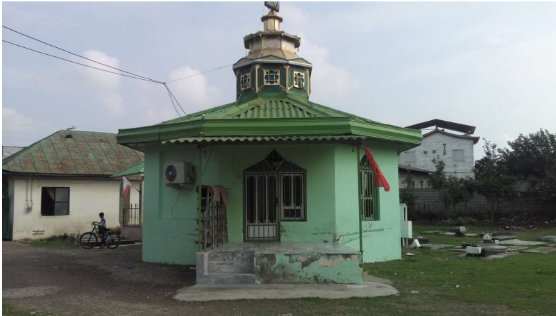
ساختمان ابوالفضلی درزی کلای دابو. (۱۳۹۶/۸/۱۹ ه.ش. عکاس: ماریا طبری)
